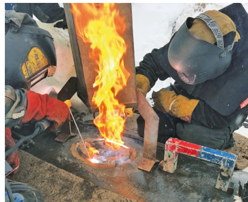
Участок 252–287 км. Выполняется заварка технологического отверстия (фото: КС-03)
