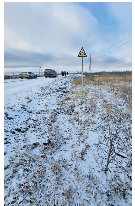
Участок автодороги, где газопровод получит защитный слой (фото: ПО ЭМГиГРС)
