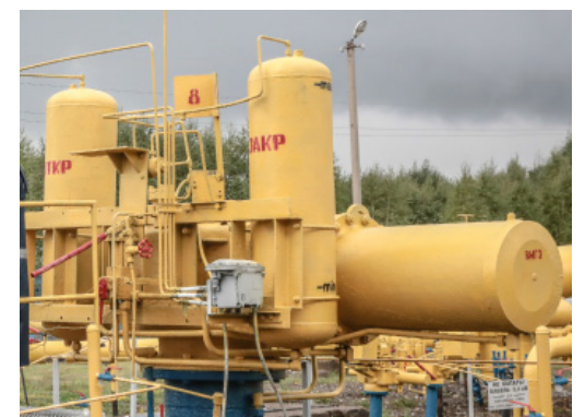
Перед применением импульсный газ необходимо должным образом подготовить. Для этого и нужны УПИГ (фото: Оксана Платоненко)
