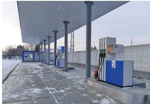
АЗС Богандинского ЛПУ, недавно прошедшая реконструкцию (фото: КС-11)
