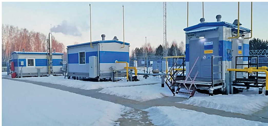
Нижнетавдинская ГРС после капитального ремонта – это уже совсем другое оборудование и совсем другой внешний вид (фото: Ярковское ЛПУ)
