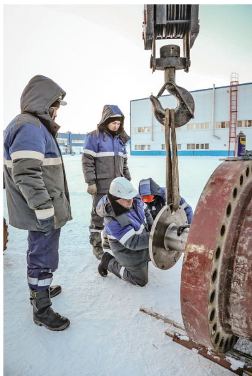
Такое оборудование не смонтировать без крана. Специалисты готовятся к установке фрезы
