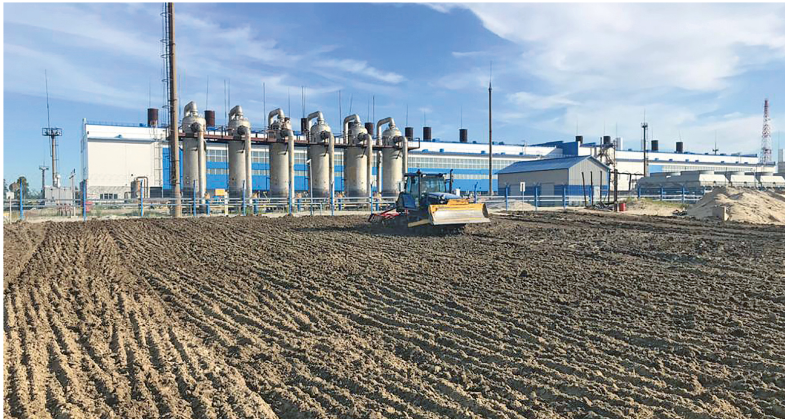
Рекультивация на КС-02. Торф уложен, проводится разрыхление почвы
