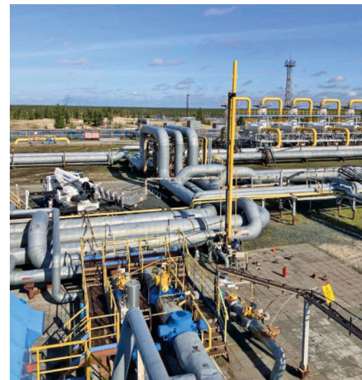
Обновленные опорные конструкции свечных трубопроводов пускового газа повысили надежность и безопасность работы оборудования при запуске ГТД
