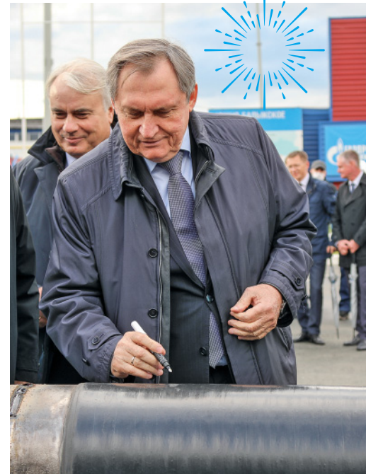
Пожалуй, главным событием года для нашего предприятия стало торжественное открытие работ по строительству газопровода-отвода «КС-5 Южно-Балыкская – г. Нефтеюганск»
