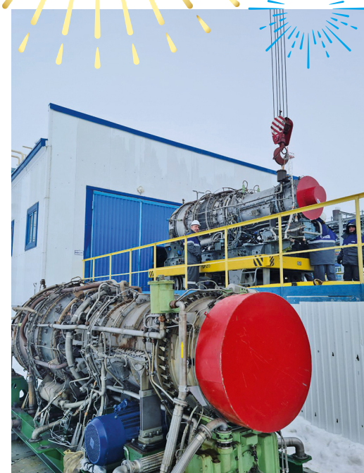
Переборка двигателей ГПА с менее загруженной КС-8 на «передний край обороны» – КС «Заполярье» позволила повысить запас надежности
