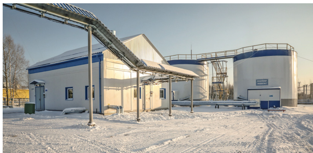
Новая насосная станция радует взгляд не только внутренним содержанием, но и внешним видом
