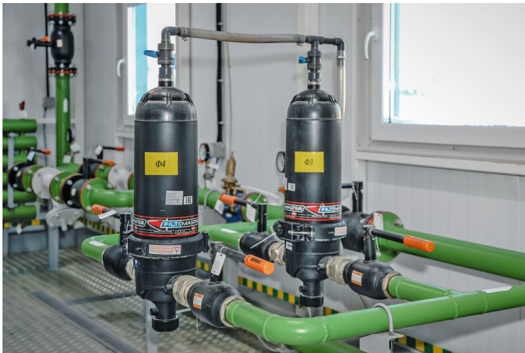
Дисковые фильтры тонкой очистки, предназначенные для удаления из воды твердых загрязнений, песка, окислы, ржавчины, тонкодисперсных примесей (фото: Оксана Платоненко)
