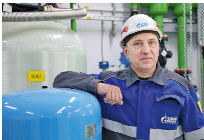
Инженер по водоснабжению Евгений Савин убежден, что новая насосная станция будет служить не один десяток лет
