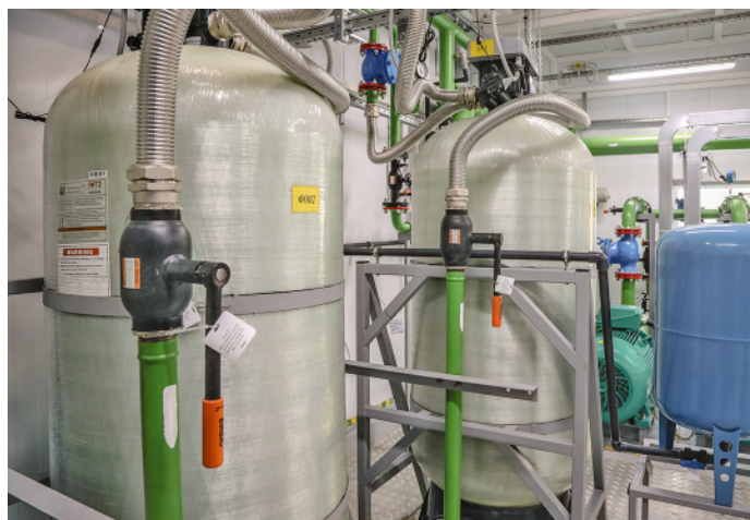
Фильтры ФОВ 3072 предназначены для осветления и обезжелезивания воды. Промываются они автоматически, согласно заданной программе
