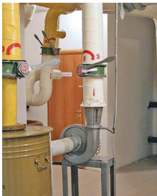
Так выглядит современная система фильтровентиляции на КС-3 (фото: специальный отдел)
