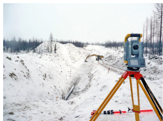
Геодезический контроль при ремонтах подводных переходов тоже необходим
