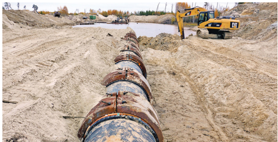
Дюкер заизолирован, обвешан пригрузами и готов к обратной засыпке. В такие моменты работа специалистов «Возрождения» очень напоминает труд наших линейщиков
