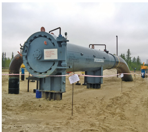
Новые камеры запуска очистных устройств на КС-1 (фото: Дмитрий Карелин)
