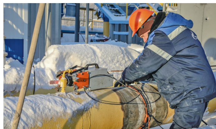
Прибор на трубе – маленький реактор, как в шутку его называют дефектоскописты
