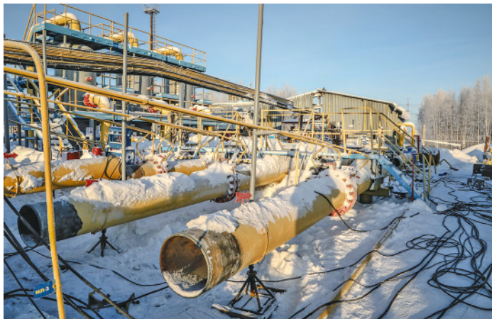
Капитальный ремонт на ГРС-3 Сургутского ЛПУ
