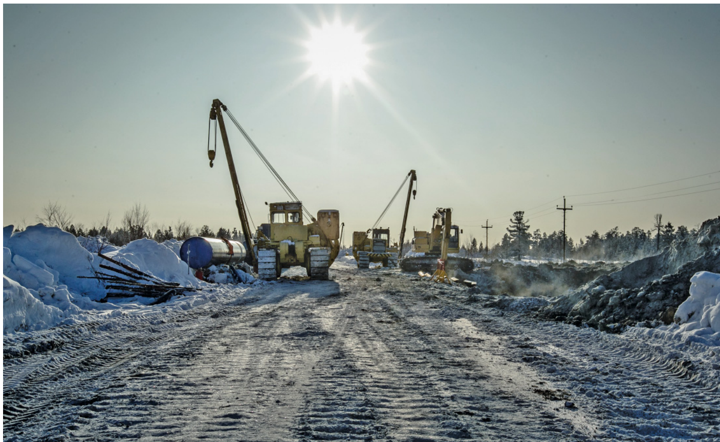
В основе стандартов УАВР – количество сваренных стыков в сутки. В основе корректировок – специфика линейной части
