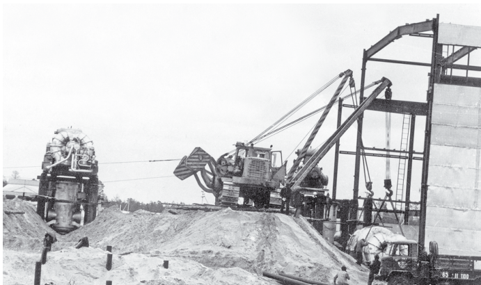
Идет строительство первой компрессорной – КС-2 «Ортъягунская»
