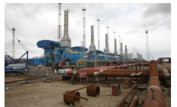
Строительство КС «Заполярье» на финишной прямой. Самая новая станция стала головной в нашей системе газопроводов
