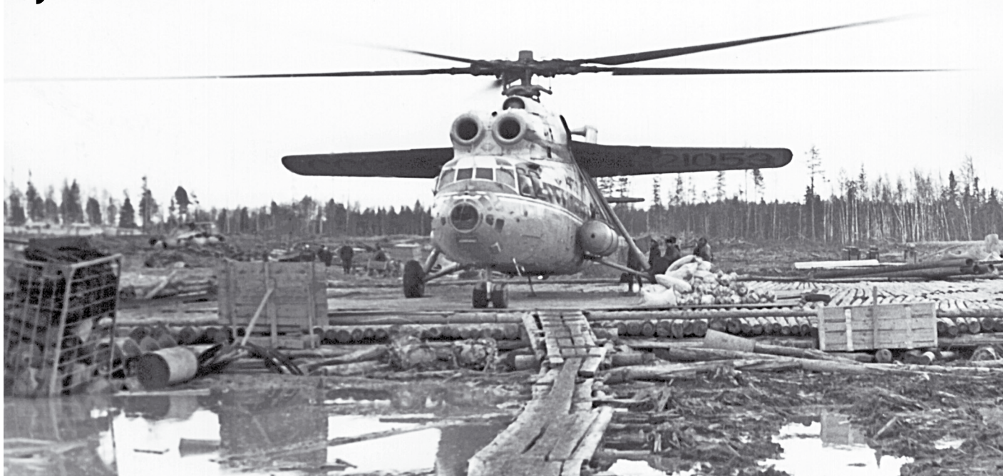
Строителей газопровода не зря прозвали первопроходцами – они нередко высаживались там, где не ступала нога человека (фото: архив редакции)
