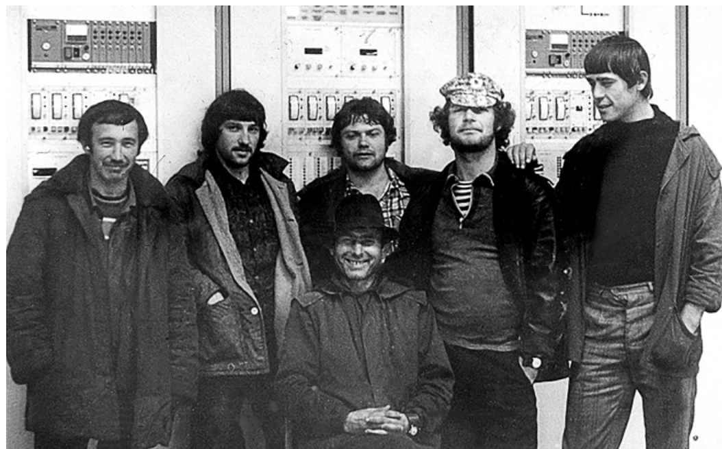
Главный щит КС-8, начало 1980-х
