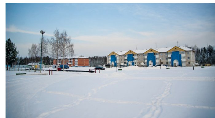
Введенные энерго мощности в поселке КС-6 перешли в дежурный режим
