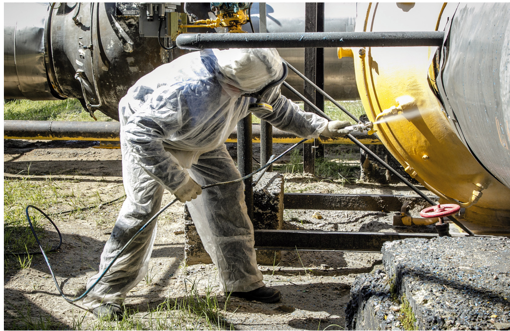
Новое антикоррозионное покрытие наносят со строгим соблюдением технологии (фото: Оксана Платоненко)
