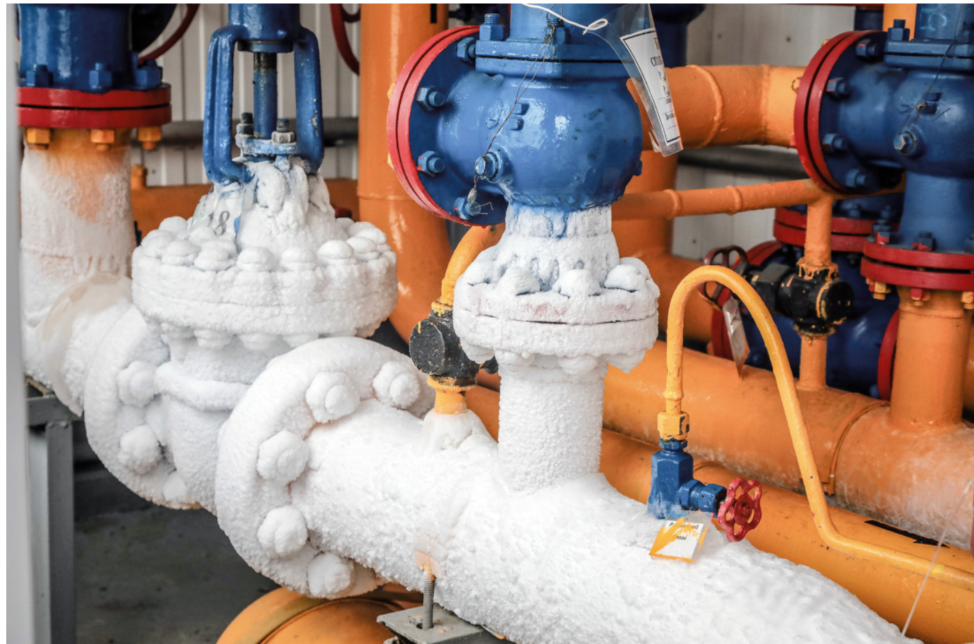
Когда давление газа резко падает, он мгновенно и порой очень сильно охлаждается. Из-за этого на трубах иногда можно увидеть вот такую ледяную «шубу». Это же явление может приводить и к образованию гидратов внутри трубы (фото: Оксана Платоненко)
