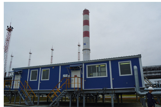
Котельная РЭМЭКС-ТТ-6,0 – основной источник тепла на Заполярной КС. Но не единственный
