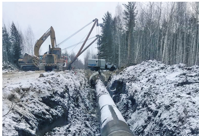
Одно из устраненных проблемных мест. Работают трубоукладчики
