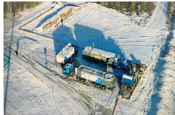
Перед началом работ газ из отключенного участка перекачали в соседнюю нитку (фото: Тобольское ЛПУ)
