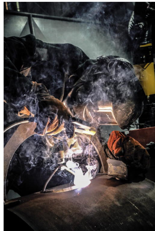
Заплата зафиксирована в проеме, сварщик начинает заваривать шов
