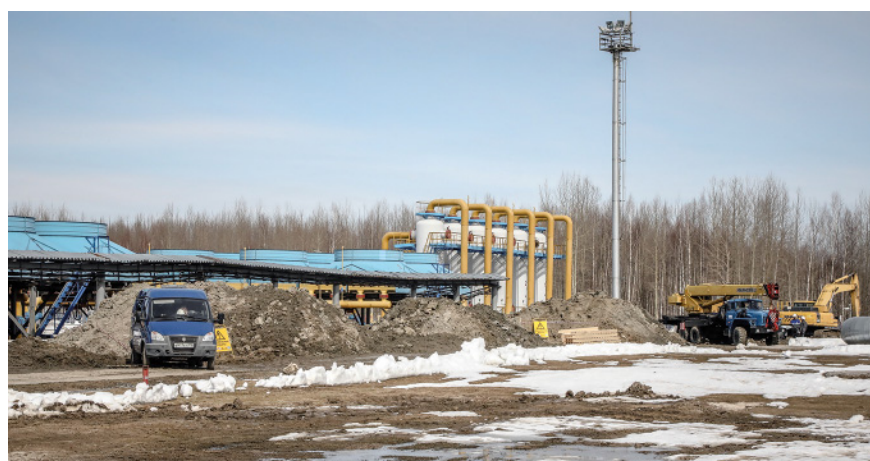
В ходе ППР на КС-5 должны обследовать почти 1,5 км. трубопроводов
