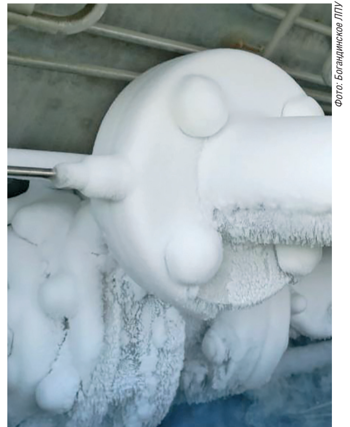
Технология крупным планом: сжиженный природный газ превращается в пар
