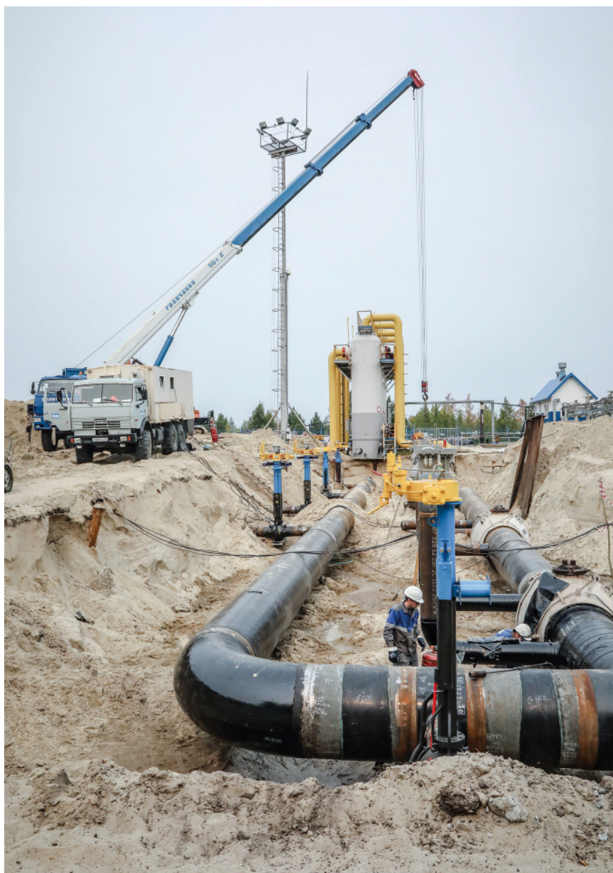
Новый коллектор узла подогрева газа обретает свой законченный вид
