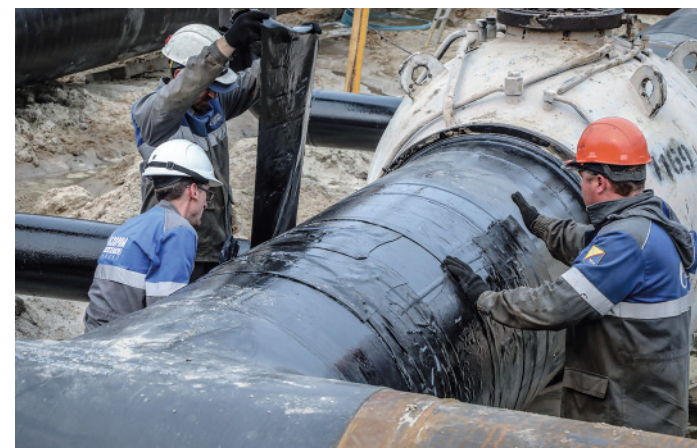
Бригада слесарей наносит изоляцию на проверенные рентгеном стыки
