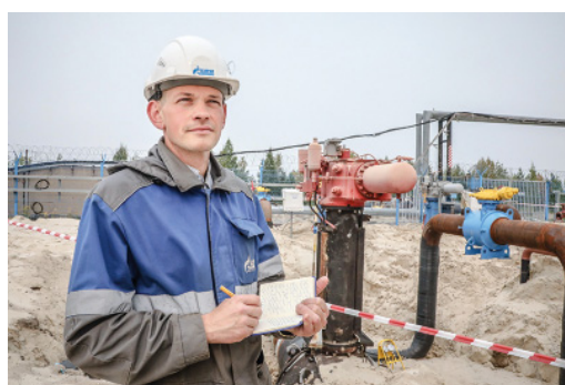
Юрий Пронин контролирует ход работ на объекте
