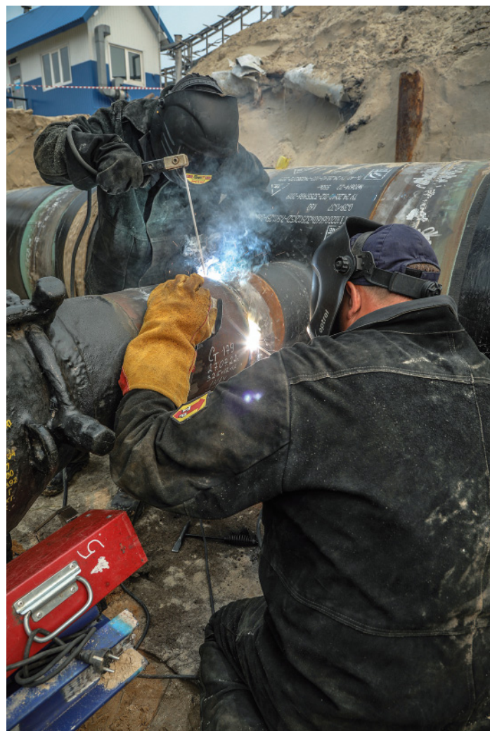
Анатолий Федориненко и Сергей Ремняков (СЛПУ) заваривают очередной шов
