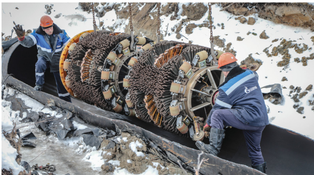
Внутритрубная диагностика – самый эффективный метод оценки состояния линейной части
