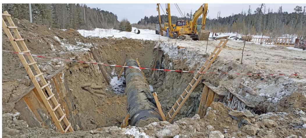
Устранение дефектов в Самсоновском ЛПУ проводили в непростых условиях (фото предоставлено КС-6)
