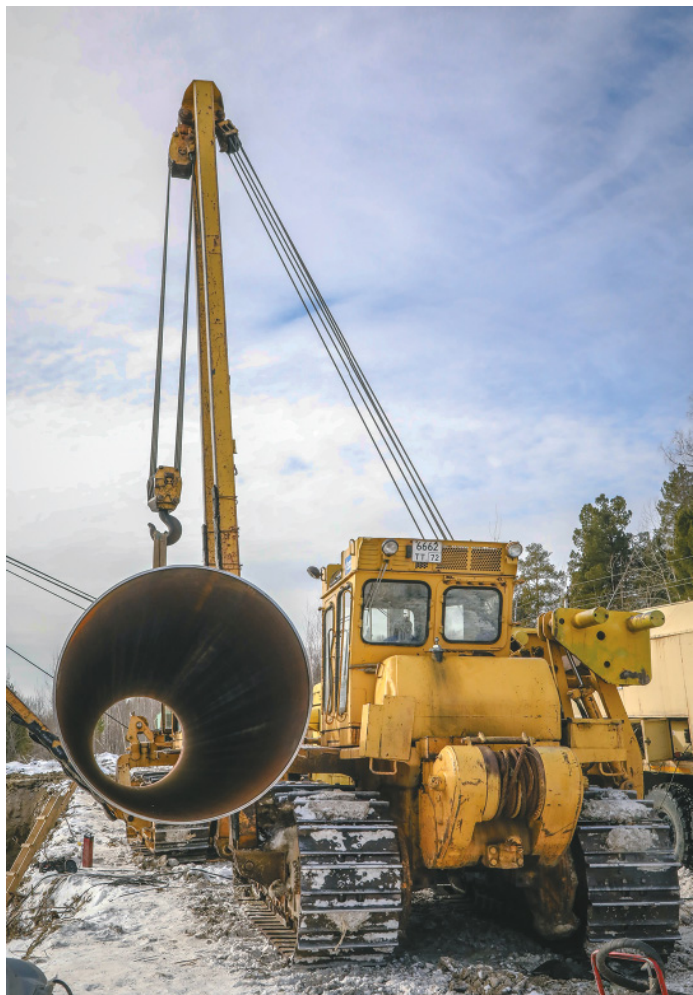
Работы по устранению дефектов на линейной части, выявленных в ходе ВТД, проводятся ежегодно
