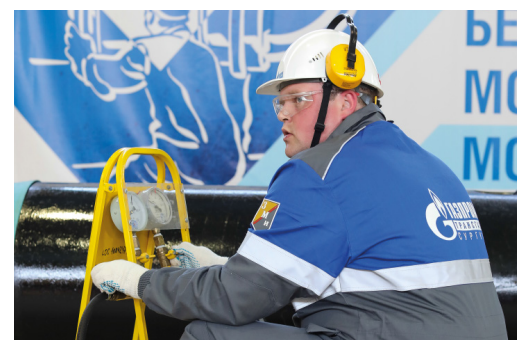
Чтобы накачать герметизирующее устройство, нужен компрессор
