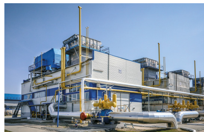
Агрегаты КС-13. На первом плане – тот самый ГПА № 11 в обновленном виде. В ближайшем будущем такой же ремонт ожидает и остальные машины
