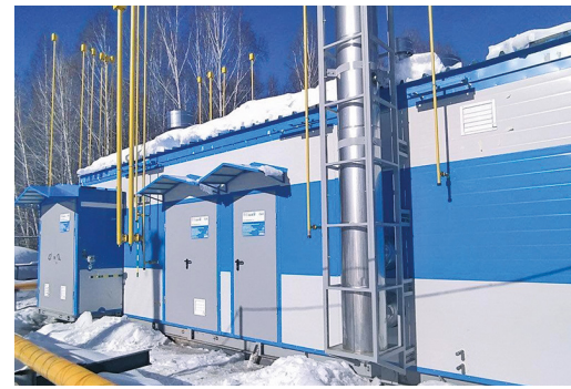
В 2022 году была полностью обновлена ГРС «Абрамовская» в рамках проведения капитального ремонта. Старое оборудование заменено на современное
