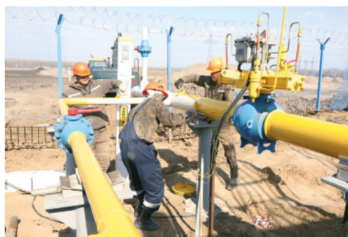
«Косметические» работы на трубопроводах: все должно быть по ГОСТу
