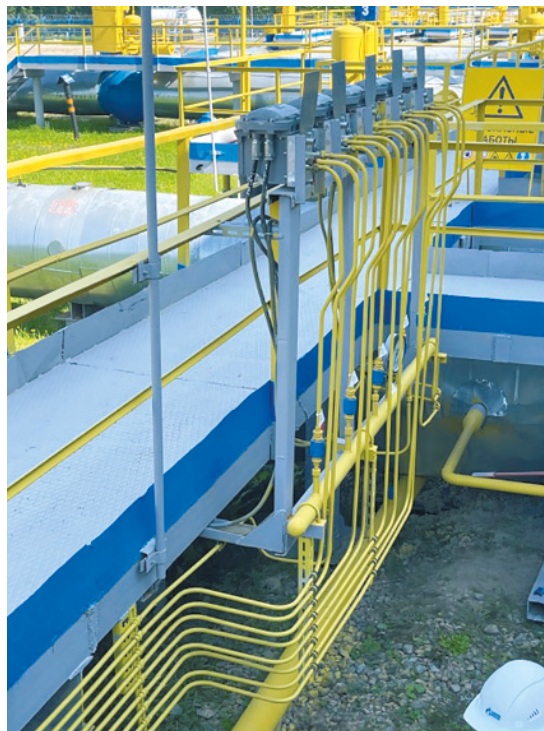
Положительный пример сборки блоков управления и импульсной обвязки кранов «гитары» на КС-5
