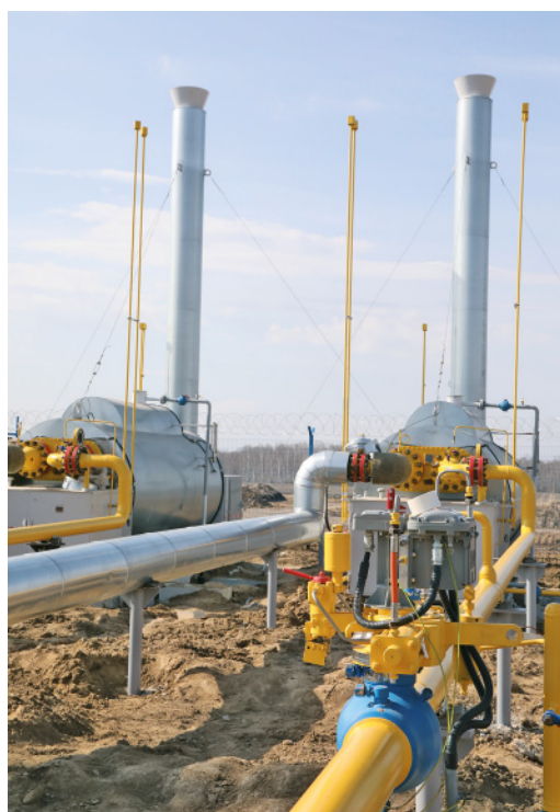
Необходимый элемент любой ГРС – подогреватель газа. На «Ишиме» их два
