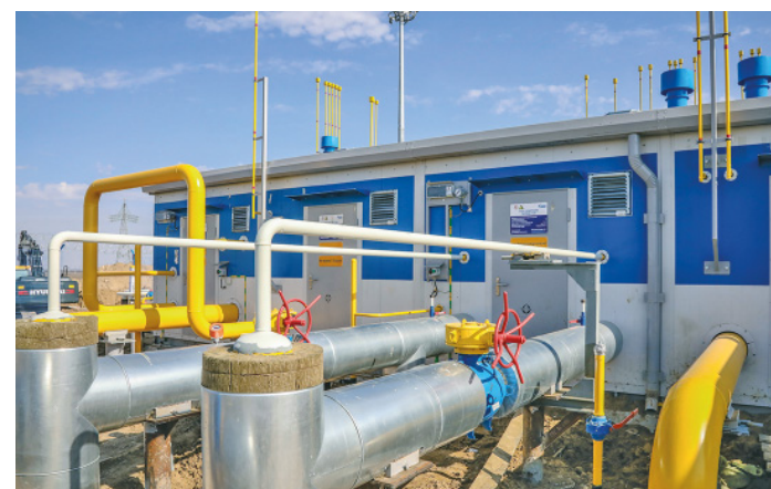
Главный модуль станции: здесь происходит подготовка газа для потребителей
