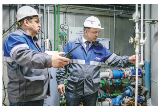
Планерка на месте: инженер ЭВС Евгений Елизаров и начальник ЛПУ Алексей Данилюк
