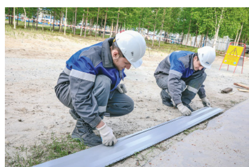
Обшивка котельной идет полным ходом. В кадре – Султан Уксукпаев и Дмитрий Лебедев
