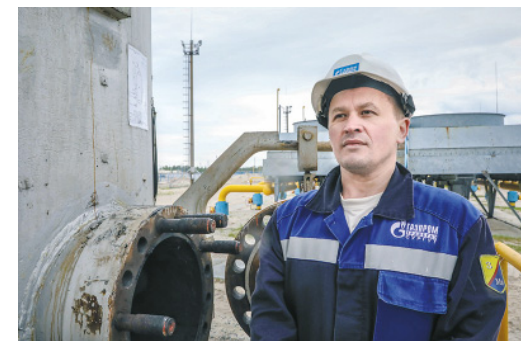
Машинист ГКС Андрей Юшков на объекте ремонта
