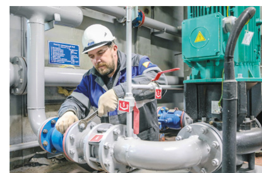
Слесарь Дмитрий Сорокин: «Главное в ремонте котельной – обновление оборудования»
