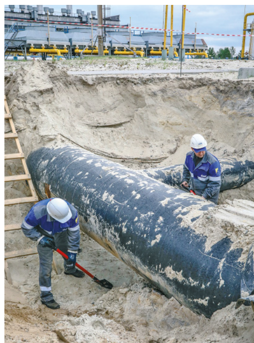
Таких котлованов на станции вырыто 14
