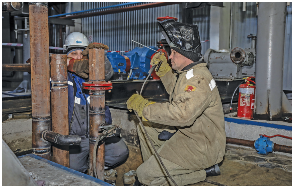
Ремонт маслосистемы хозяйственным способом на КС «Приобская» Сургутского ЛПУ
