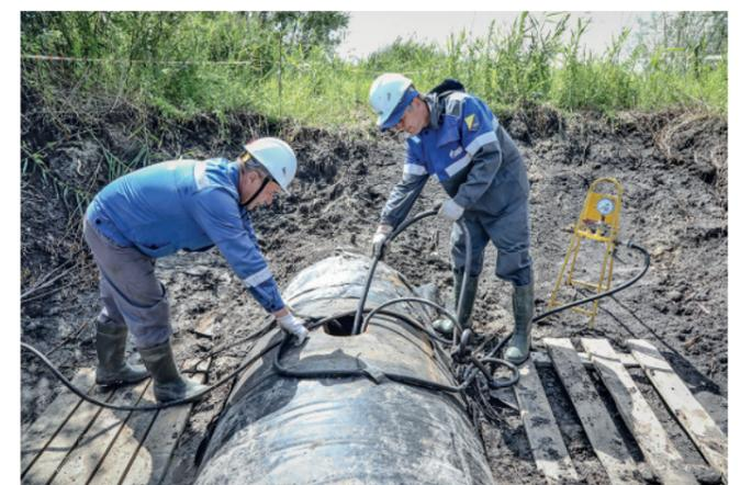
Линтрубы Богандинского ЛПУ устанавливают в полость трубы временное герметизирующее устройство
