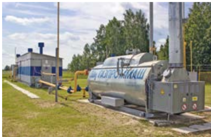
Старые ГРС модернизируются. Например, обзаводятся новыми подогревателями газа
