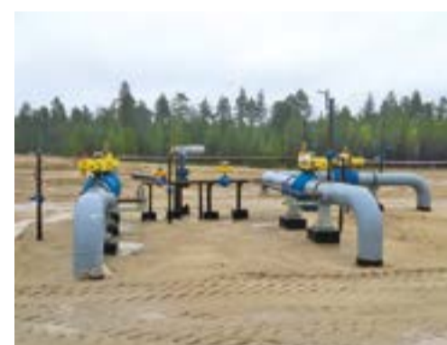
Средства телемеханизации позволяют управлять кранами дистанционно
