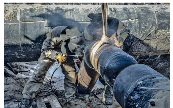
Сейчас сварят последний стык, и подогреватель можно будет считать подключенным
