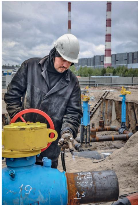
Монтаж технологических трубопроводов – дело ответственное, требующее тонкой обработки соединяемых поверхностей
