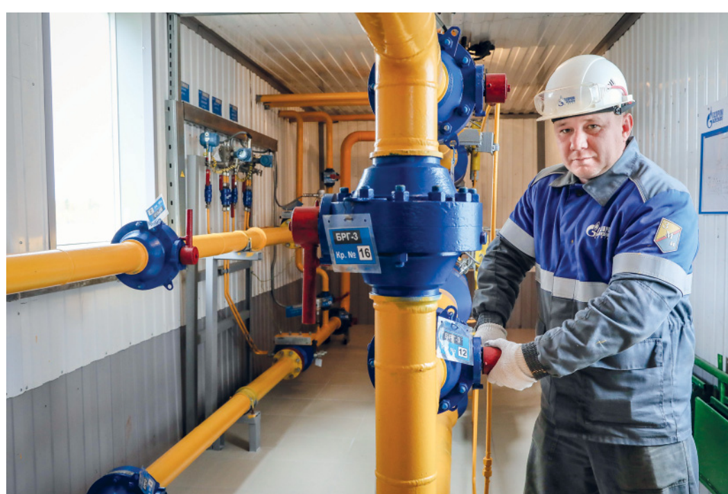
Константин Тарганов на прошедшем капремонте блоке редуцирования газа № 3 Вынгапуровского ЛПУ
