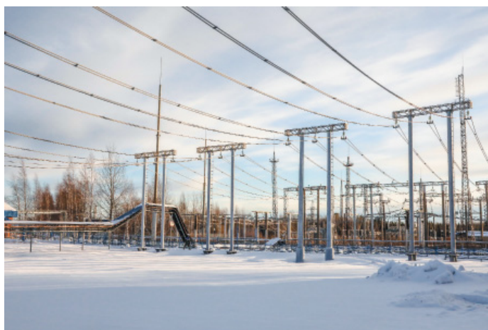
Компрессорная станция в составе двух цехов, оснащенных агрегатами СТД-12500, потребляет порядка 200 мегаватт! Поэтому сети исключительно высоковольтные
