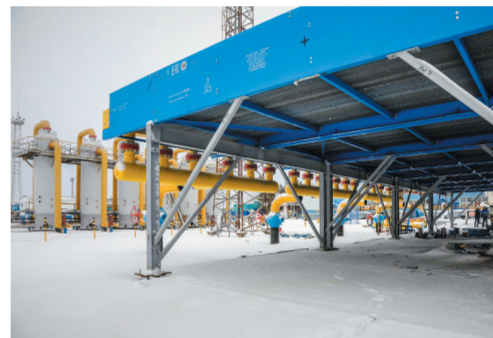
Наша конструкция АВО газа имеет более высокие опоры, что делает ее функциональнее
