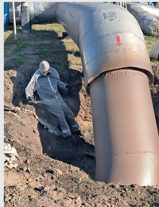
Нанесение изоляционного материала на трубу на границе земля-воздух
