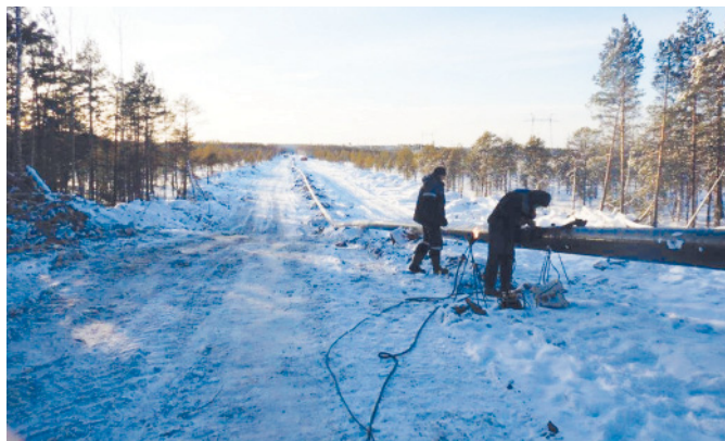
Протяженность газопровода-отвода – более 47 километров
