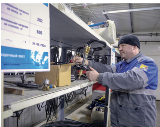
На КС-5 три сварочных поста и все содержатся в идеальном порядке
