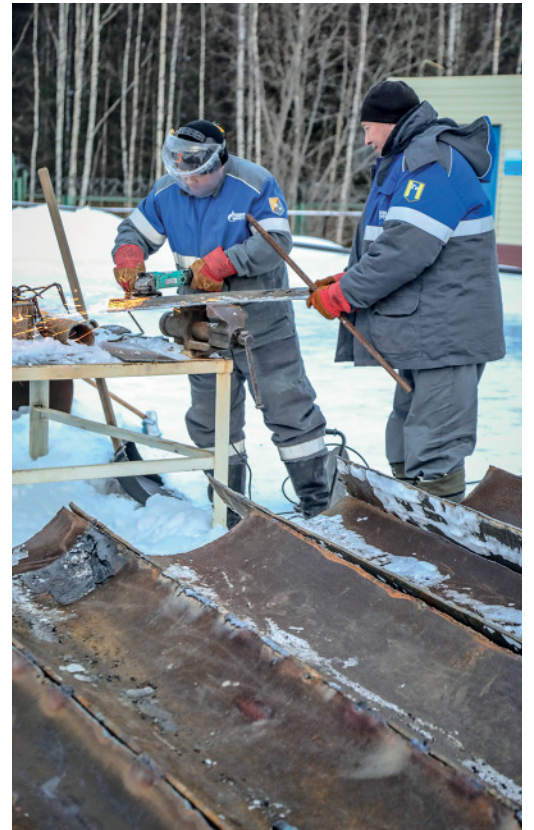
У персонала РЭП всегда большой объем сварочно-монтажных работ
