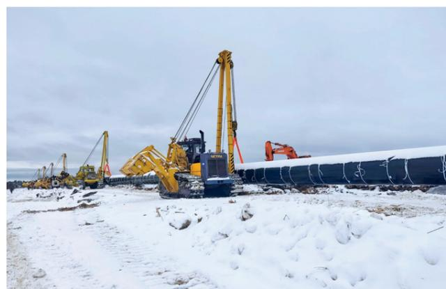
Укладка в траншею такой длинной заготовки – сложная и ответственная задача
