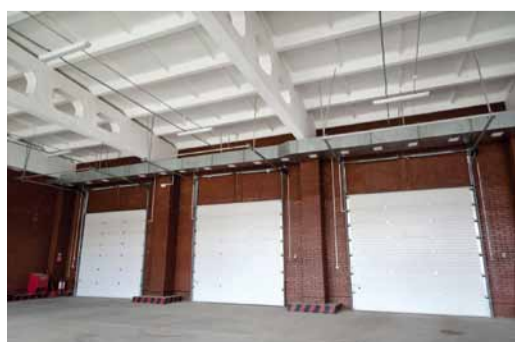
В просторном боксе от непогоды могут укрыться одновременно 12 автомашин...
