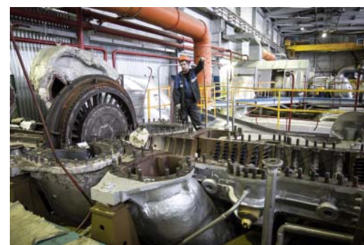
В Губкинском ЛПУ в ремонт вывели два агрегата
