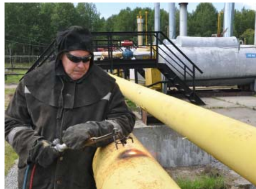
Обжиг трубы под технологическое окно
