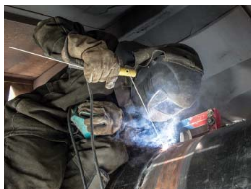
Сварка стыков – в специальных укрытиях
