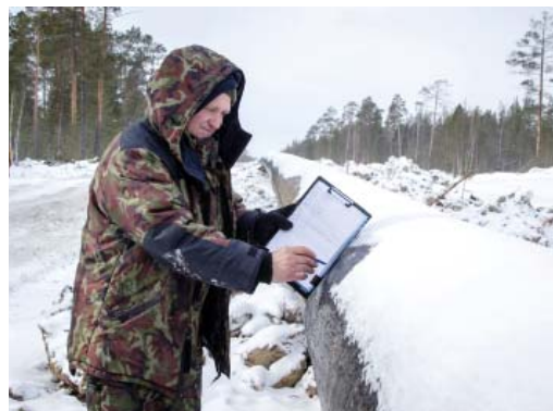
Вскрытый трубопровод детально обследуется
