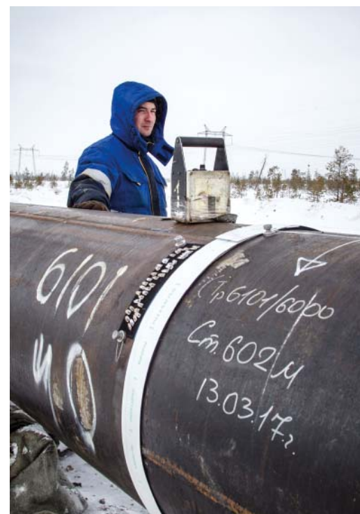
Тут же проверяют качество швов
