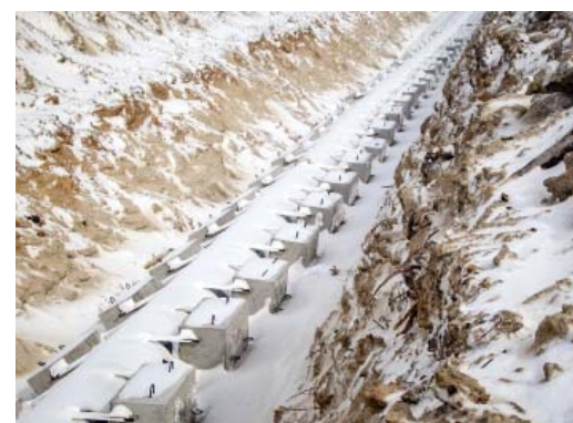
Сварили, заизолировали, забалластировали...
