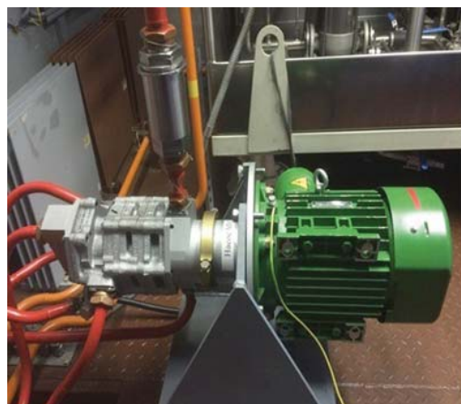
Дополнительный насос, обеспечивающий прокачку масла, и шкаф управления системой
