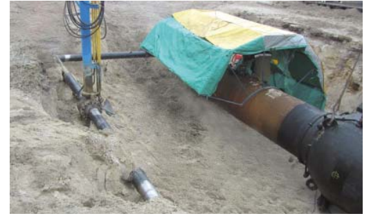
Работы в районе КЦ-1 Губкинского ЛПУ
