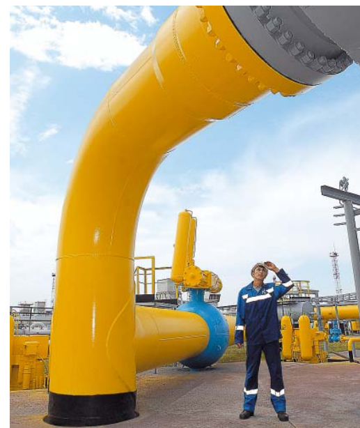
Осмотр и диагностика трубопроводов дадут представление об остаточном ресурсе их эксплуатации
