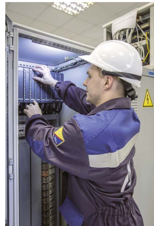
В Обществе продолжают капремонты агрегатной автоматики
