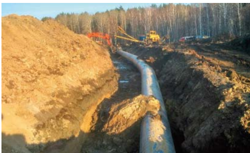
Сложный рельеф местности в районе КС-8 осложняет монтажные работы
