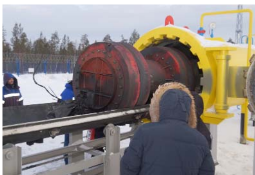
Очистной поршень запускается в трубу
