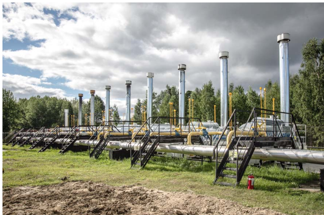
ГРС «Тобольская» после ремонта вновь снабжает газом потребителей
