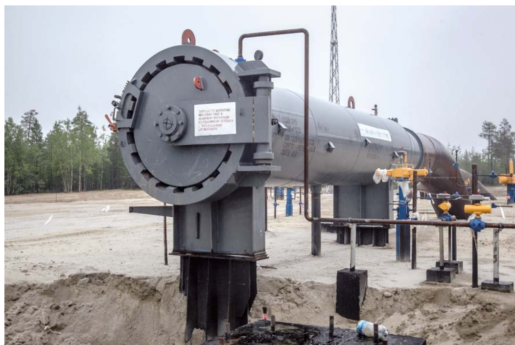
Камеры приема-запуска поршней в Вынгапуровском ЛПУ (на этапе строительства)
