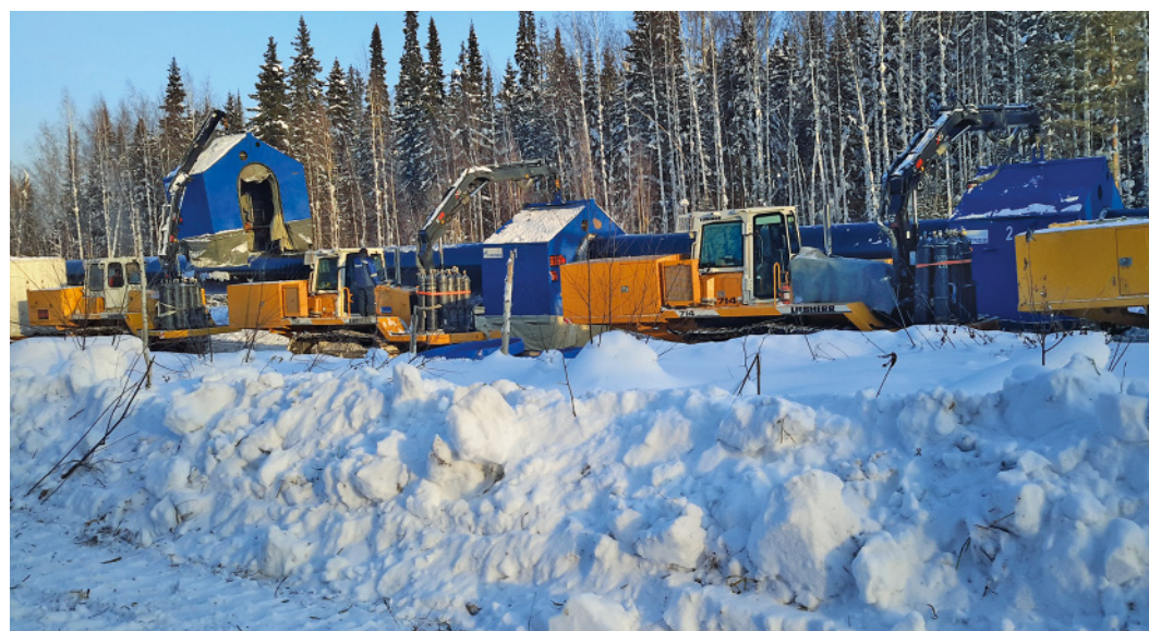
Новую трубу варят «плетями» и уже потом укладывают в траншею
