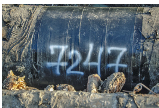
Порядковый номер трубы с дефектом
