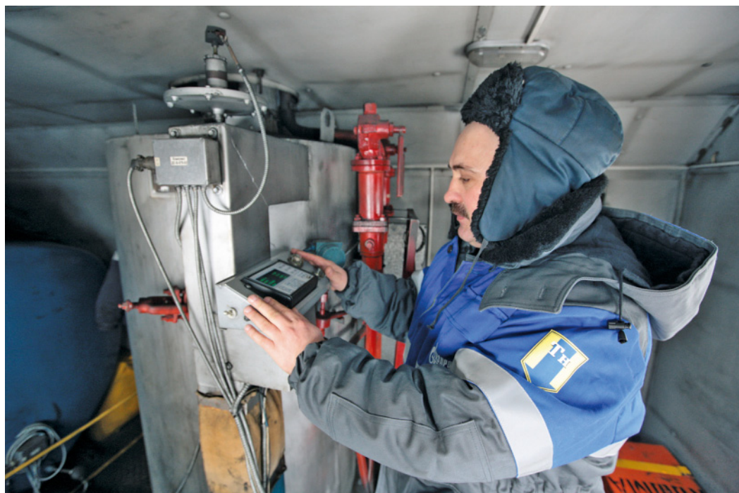
Параметры работы котла, насоса и прочего оборудования необходимо постоянно контролировать (фото: Андрей Ончев)
