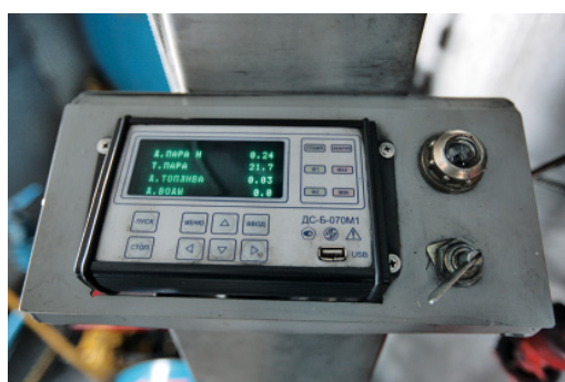
Пульт управления передвижной котельной
