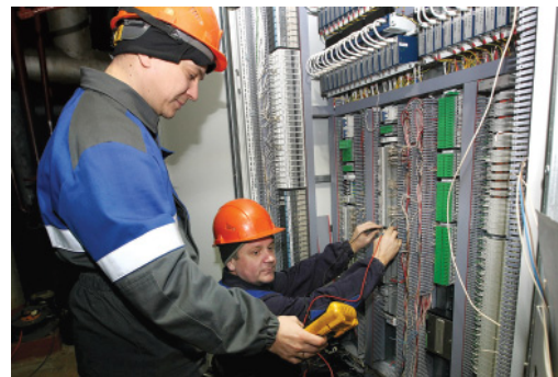
Старую автоматику ГПА меняем на новую
