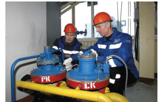
Производим ТО кранов
