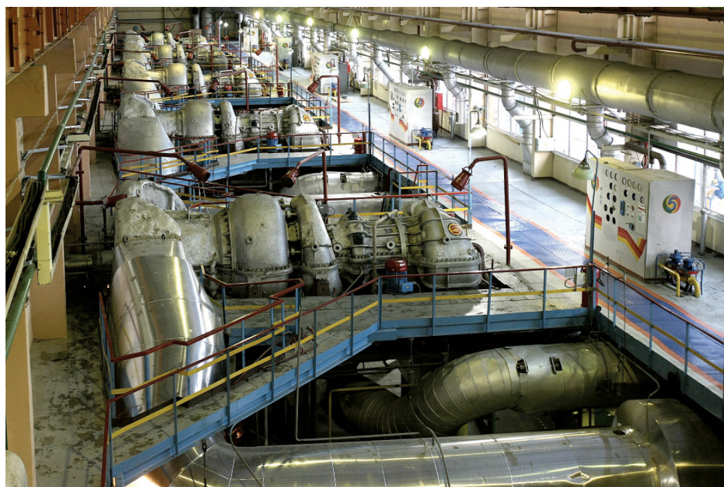
КС-01 и КС-02 долго стояли в резерве, но теперь их мощности снова востребованы
