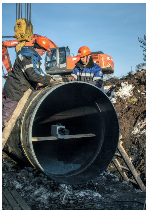
Дефектоскописты службы диагностики МГ и НК проверяют сварной шов на трубе 1420 мм
