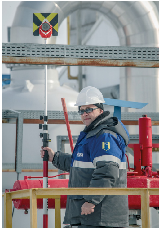
Инженер службы строительного контроля Максим Баикин следит за ходом КРТТ
