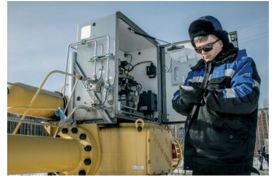
Алексей Власов, инженер службы по диагностике и обследованию запорной арматуры, ведет наладку привода крана
