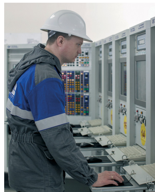
Инженер по наладке и испытаниям Сергей Тупарев вносит изменения в систему автоматического регулирования ГПА
