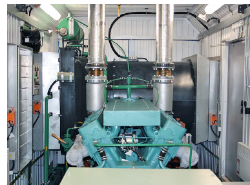
Одна из введенных в строй на объектах Общества электростанций
