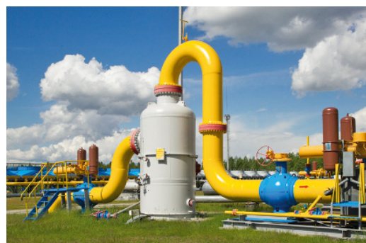
Часть оборудования уже играет новыми красками
