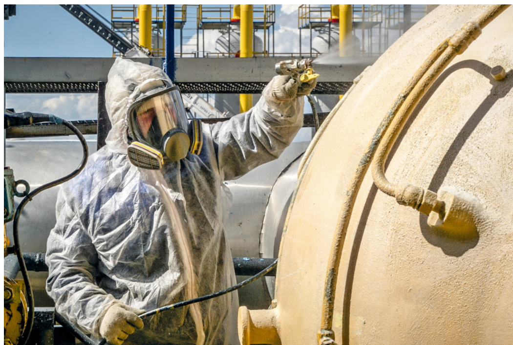
Старый слой краски сначала растворяют химической смывкой, а затем удаляют при помощи гидроструя под высоким давлением
