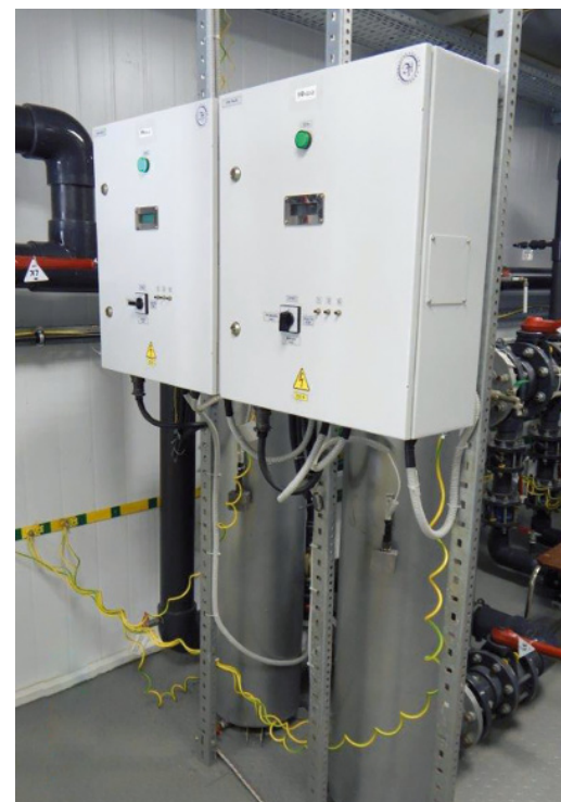
Блок ультрафиолета на установке очистки воды КС-5
