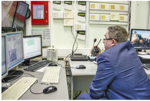
Зафиксировав «возгорание», специалист СКЗ передает сигнал пожарной тревоги по громкой связи
