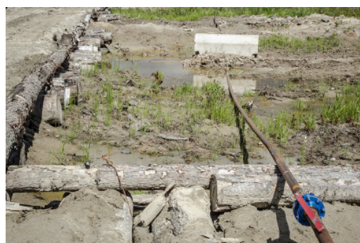
Нагнетающий шлейф прокладывают перпендикулярно заготовке и пригружают
