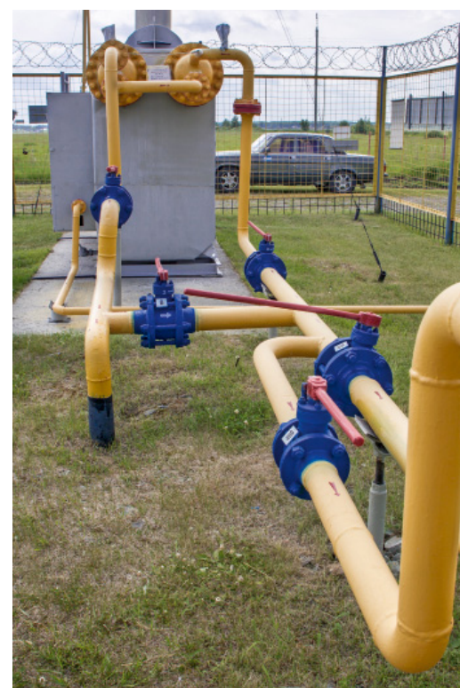
Карасульскую ГРС ожидает капремонт систем газораспределения и газопотребления
