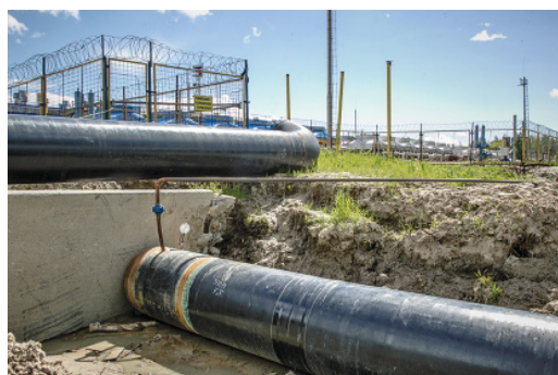
С двух сторон участка для безопасности устанавливаются отбойные плиты
