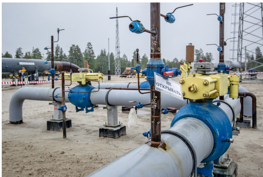
Внедрение камер запуска в Вынгапуровском ЛПУ
