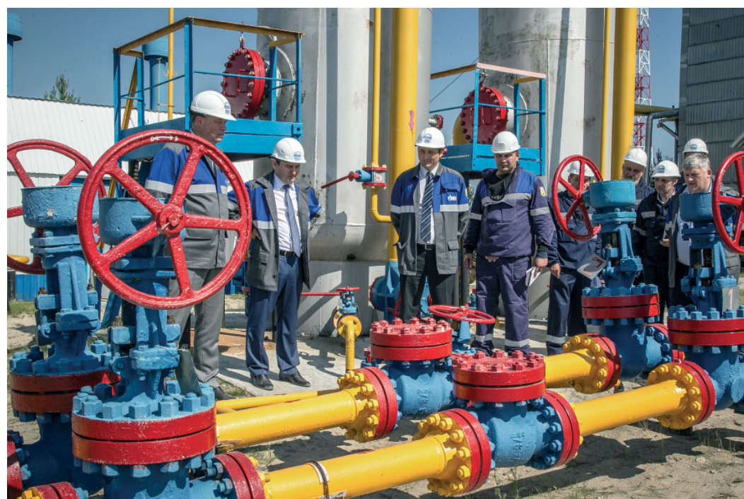
Все оборудование должно быть в идеальном порядке – от фланцев до маркировки
