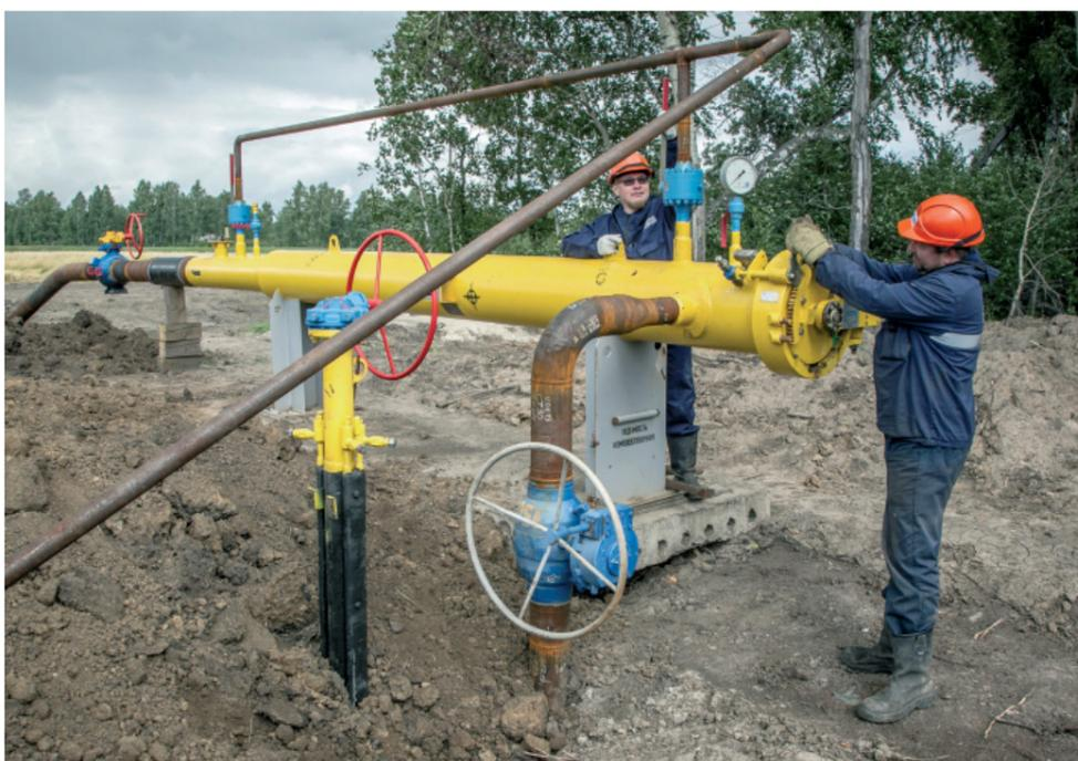
Для проведения ВТД на газопроводе-отводе ГРС «Упоровская» были смонтированы камеры приема-запуска
