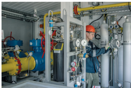
Ремонт предусматривал полную замену оборудования станции
