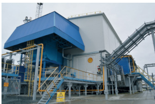
Самые мощные агрегаты в Обществе – ГПА-25 «Урал» – расположены на Заполярной промплощадке
