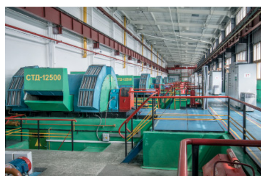
КС «Тобольская» – одна из электроприводных станций, укомплектованных ГПА СТД-12500
