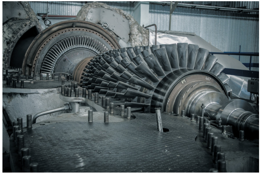
Основной источник шума в газоперекачивающем агрегате – вращающиеся роторы. На снимке – ротор турбины ГТК-10-4
