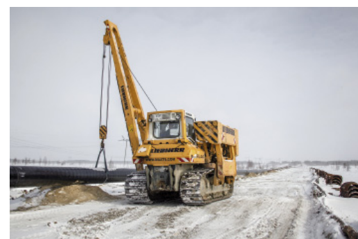
Большой объем работ на трассе предстоит выполнить собственными силами
