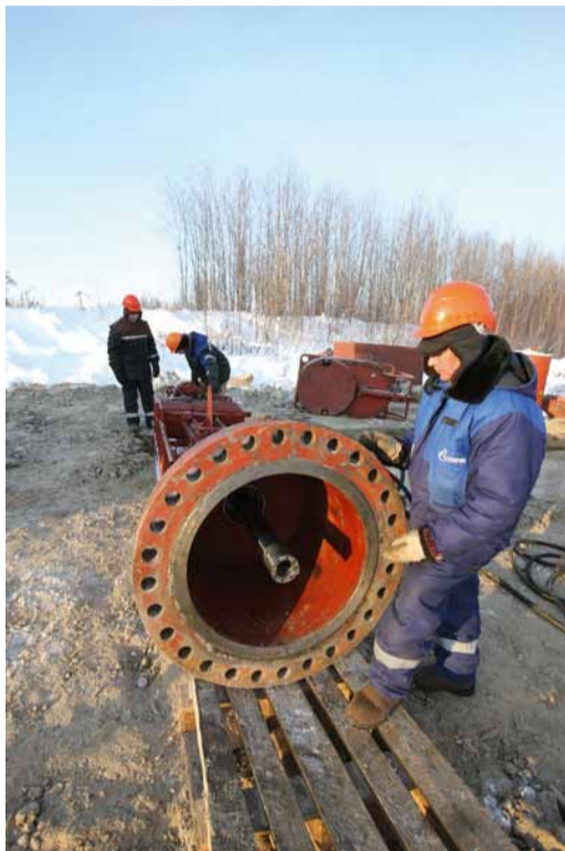
Установку безогневой врезки газовики начали применять в 1997 году и ни разу о ней не пожалели
